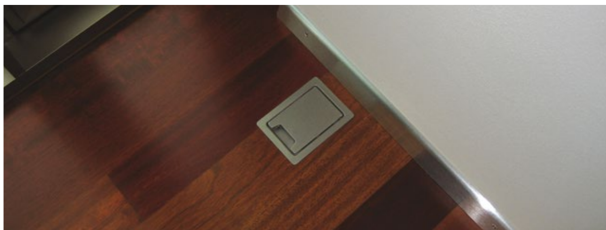
Bild 11. Die sehr elegante und hoch widerstandsfähige Edelstahldose kann unterputz in die Wand, aufputz an die Wand montiert und auch in den Boden eingelassen werden.
