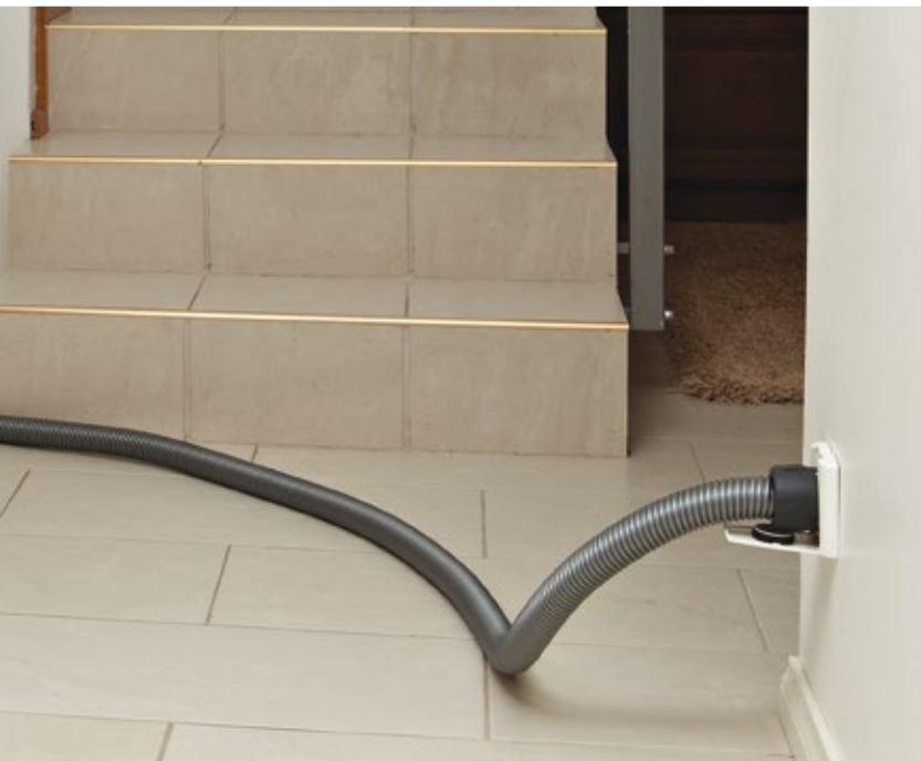
Bild 5. Der Optima Montagebauteil ist schnell und einfach in allen Arten von Wandkonstruktionen einzubauen, da es viele Befestigungsmöglichkeiten gibt. Wegen der Symmetrie der Saugdose kann auch nach der Montage die Öffnungsrichtung frei gewählt werden.
