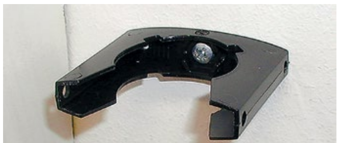
Bild 5. Montage der Rohrschelle für axiale Bewegungsfreiheit bei Befestigung durch eine Schraube in der Mitte.
