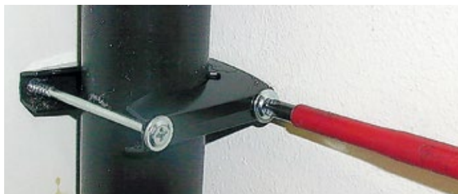
Bild 3. Die Rohrschelle kann auch von der anderen Seite montiert werden. Die Rohrschelle fixiert das Rohr in axialer Richtung.
