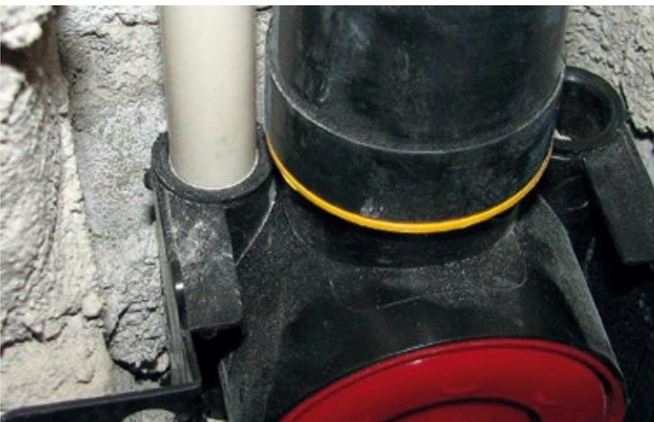
Bild 11. Das Schutzrohr ist besonders wichtig, wenn die Verkabelung durch Mauerwerk oder Beton verläuft.
